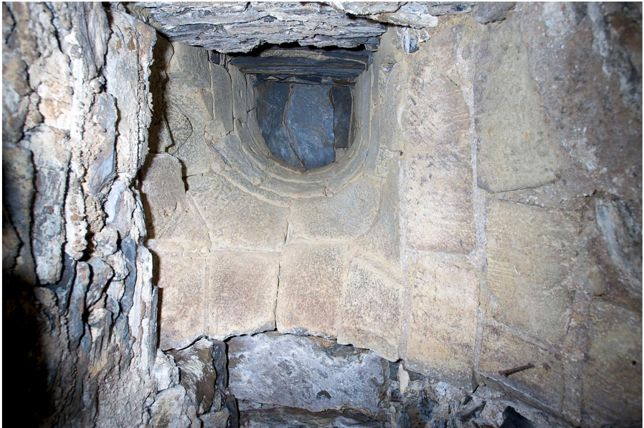
Corps de bâtiment du petit séminaire, sous-sol : cave 1, angle postérieur gauche, puits, vue à la verticale depuis le bas.
