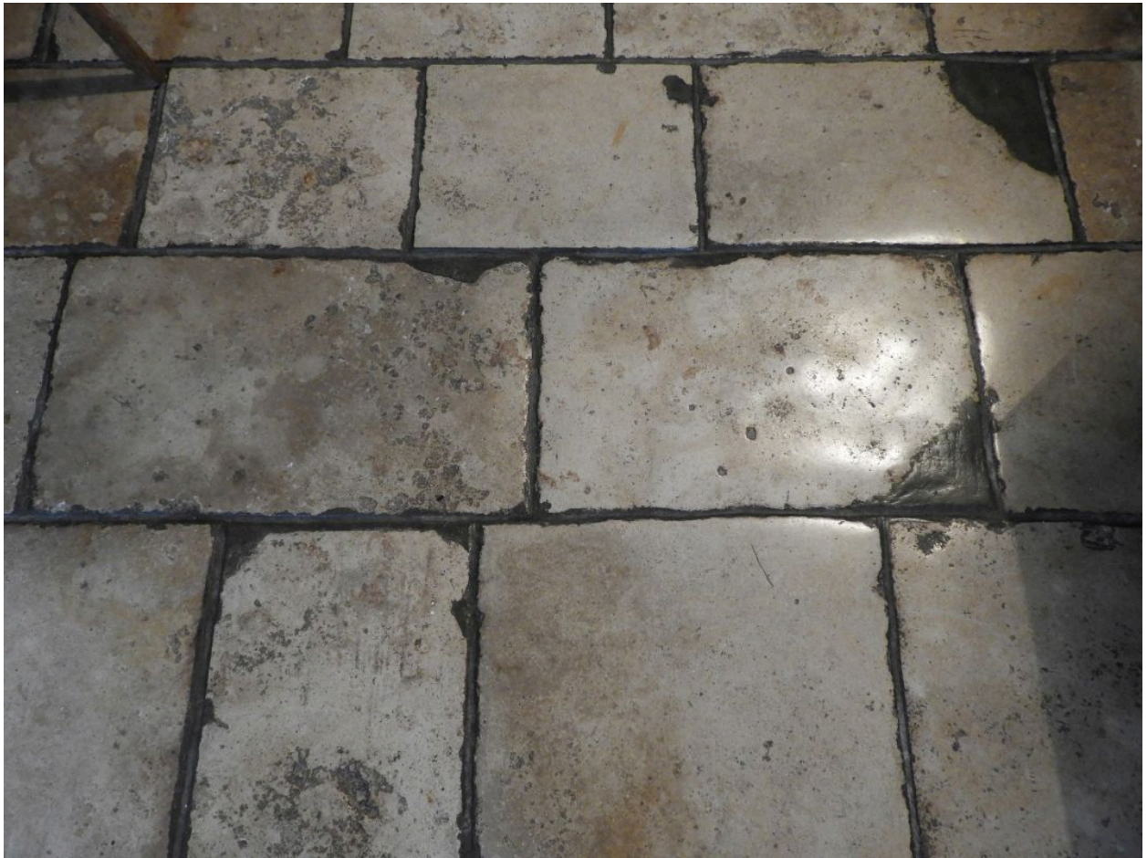
Pavement en pierre de taille de la cuisine.
