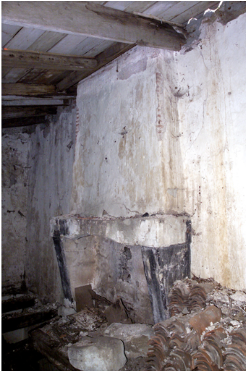
Premier étage, première pièce (ouest), détail de la cheminée.
