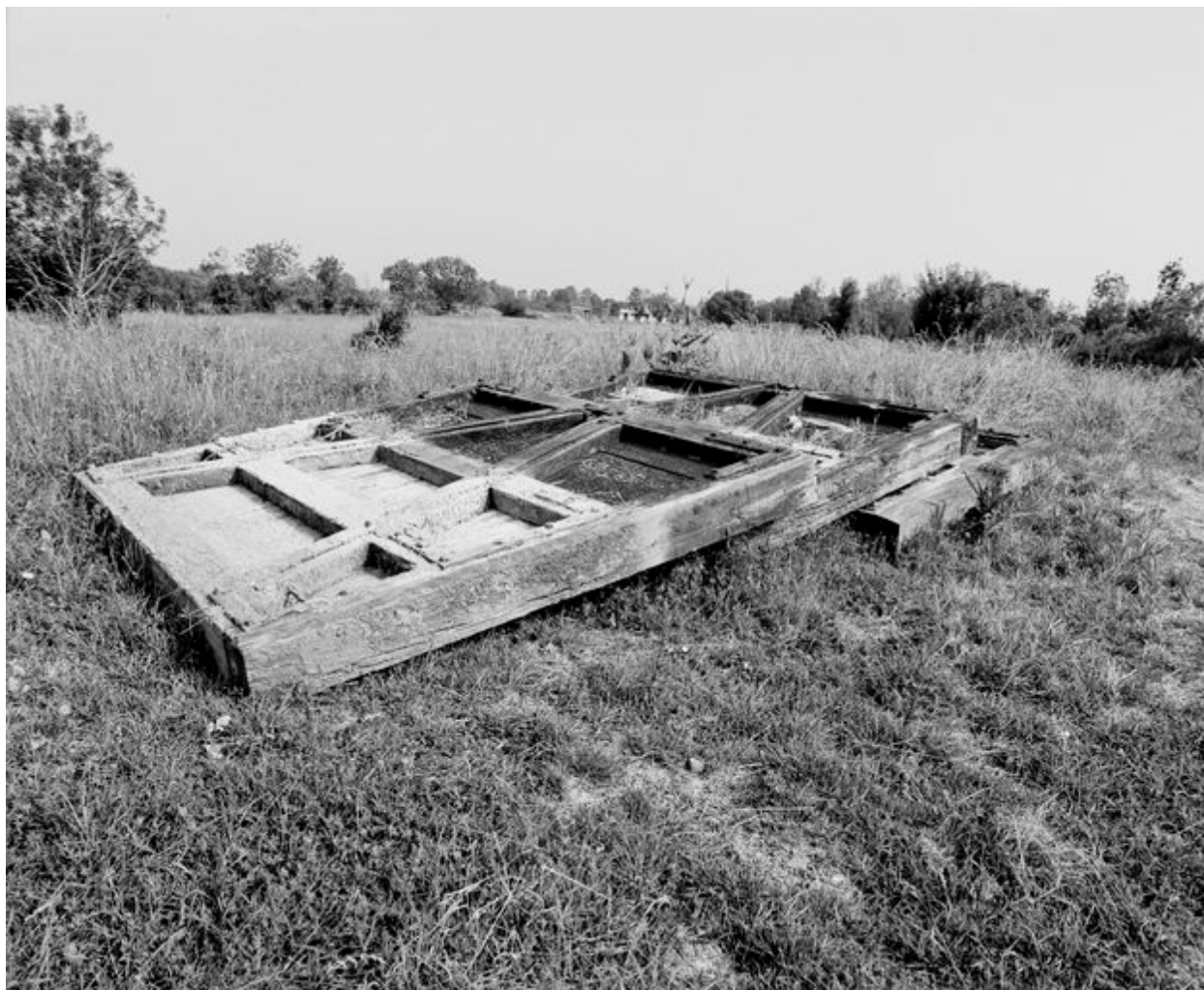
Vue des portes-vannes déposées, en 1999.
