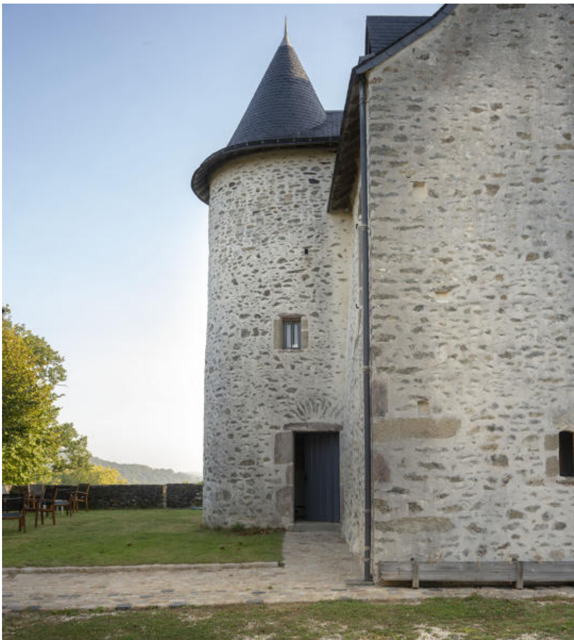
La tour d'escalier.
