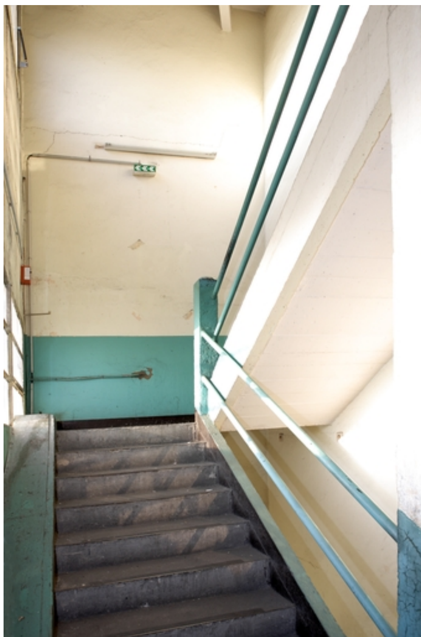
Atelier de fabrication 1, escalier de la pointe.
