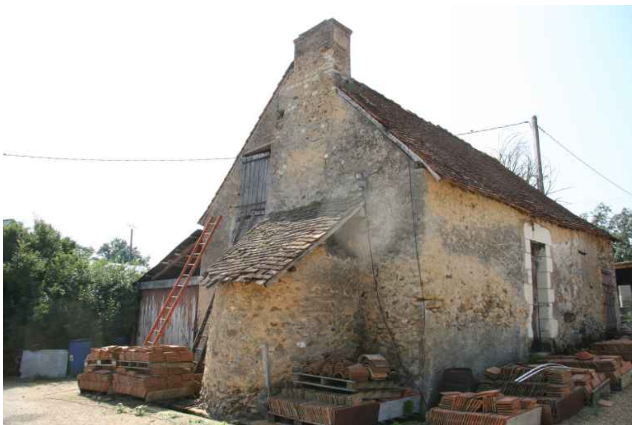
Maison n°4 : salle à cheminée sans fenêtre.
