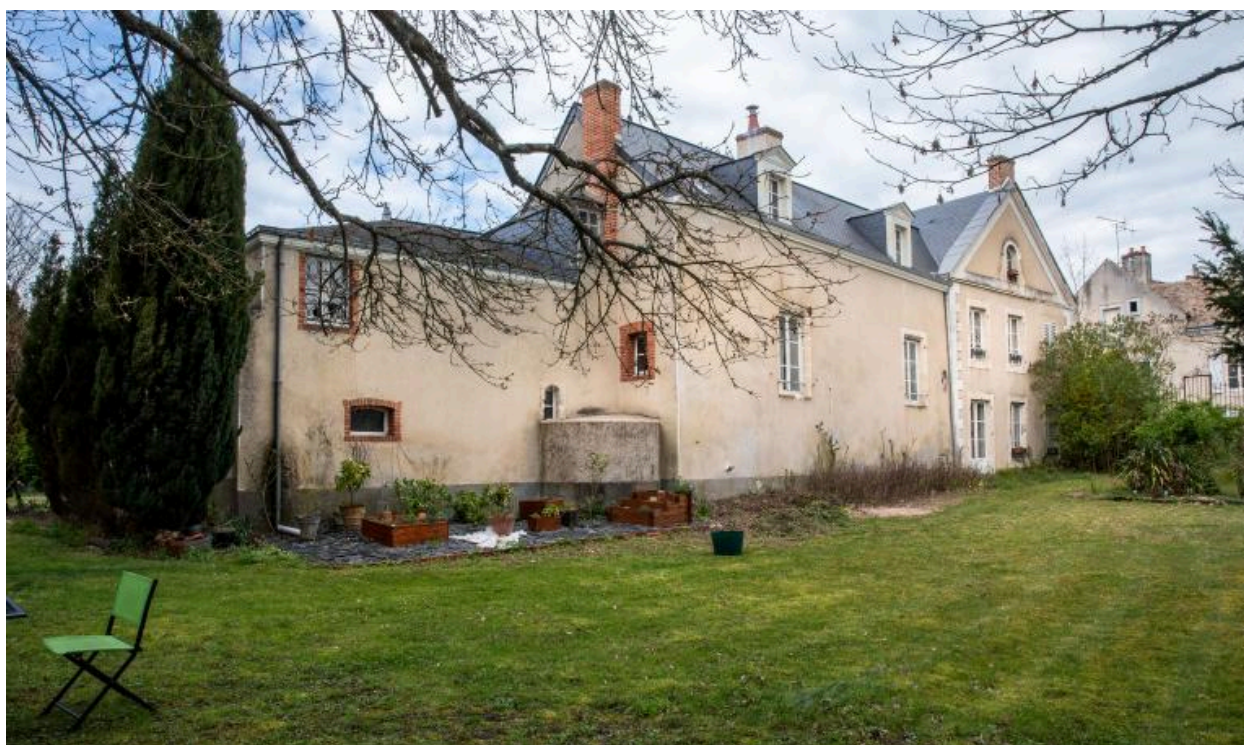
Les façades donnant sur l'Huisne.
