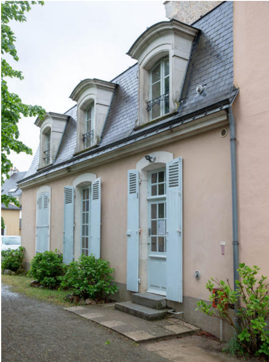
Vue du corps latéral sud du presbytère.
