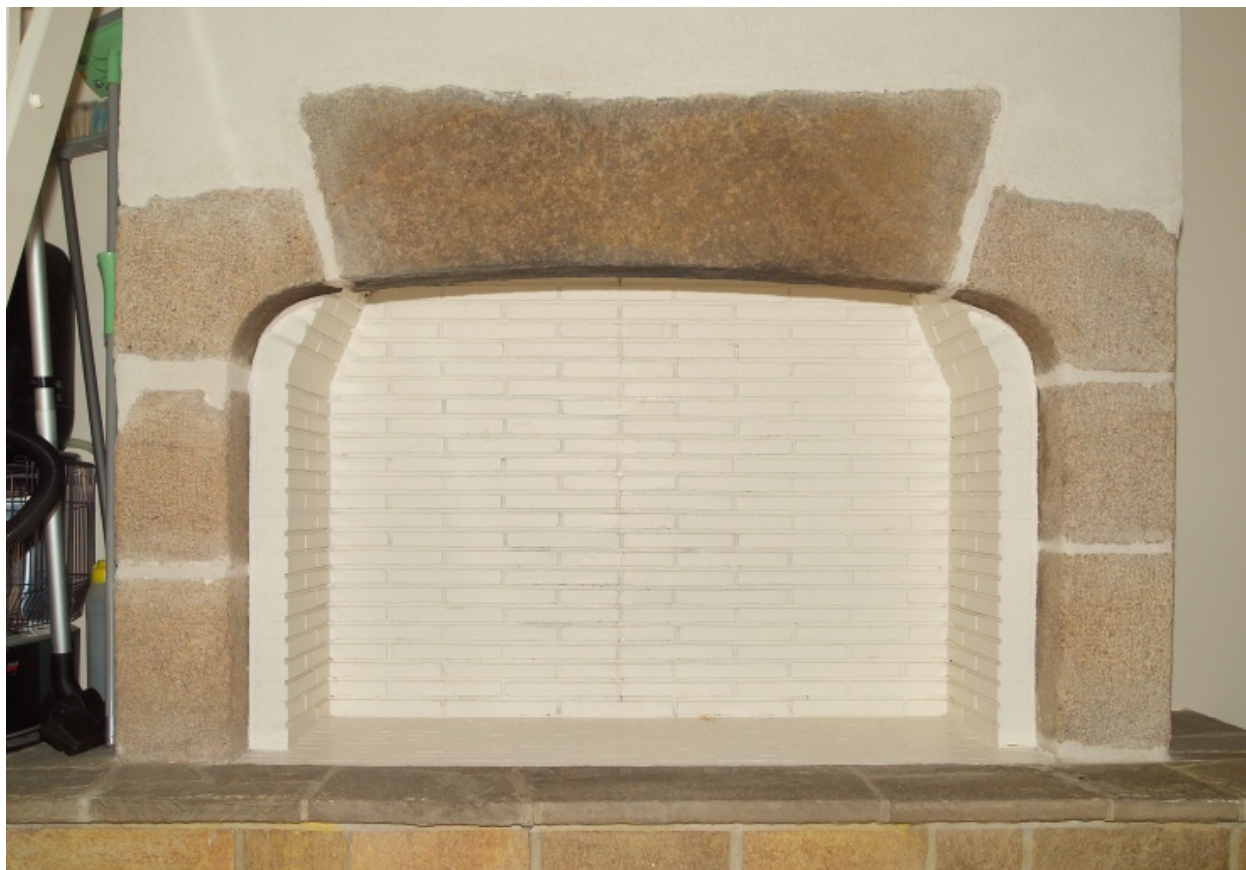
Cheminée au premier étage.
