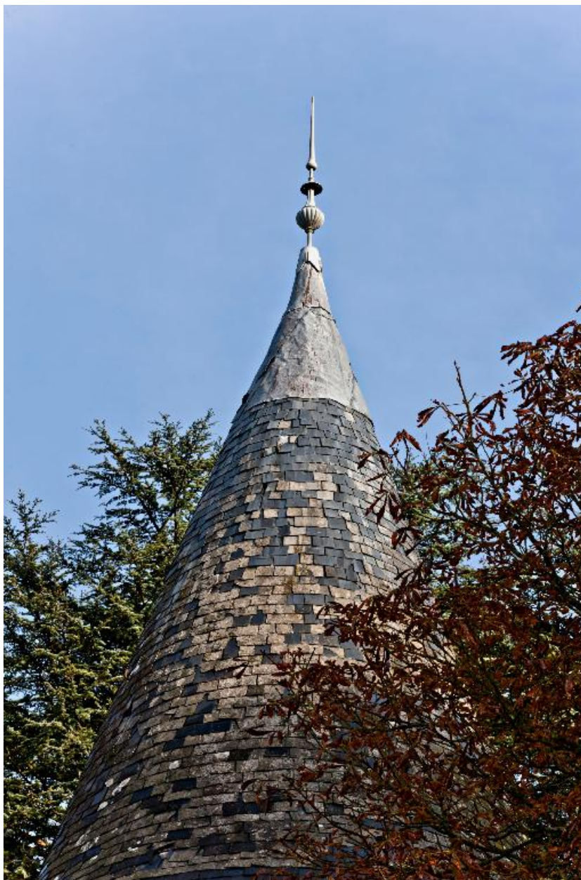
La toiture et l'épi de faîtage de la tourelle sud-est.
