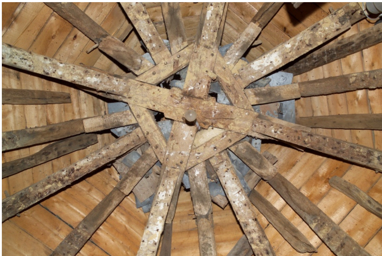
Charpente de la tour d'escalier.
