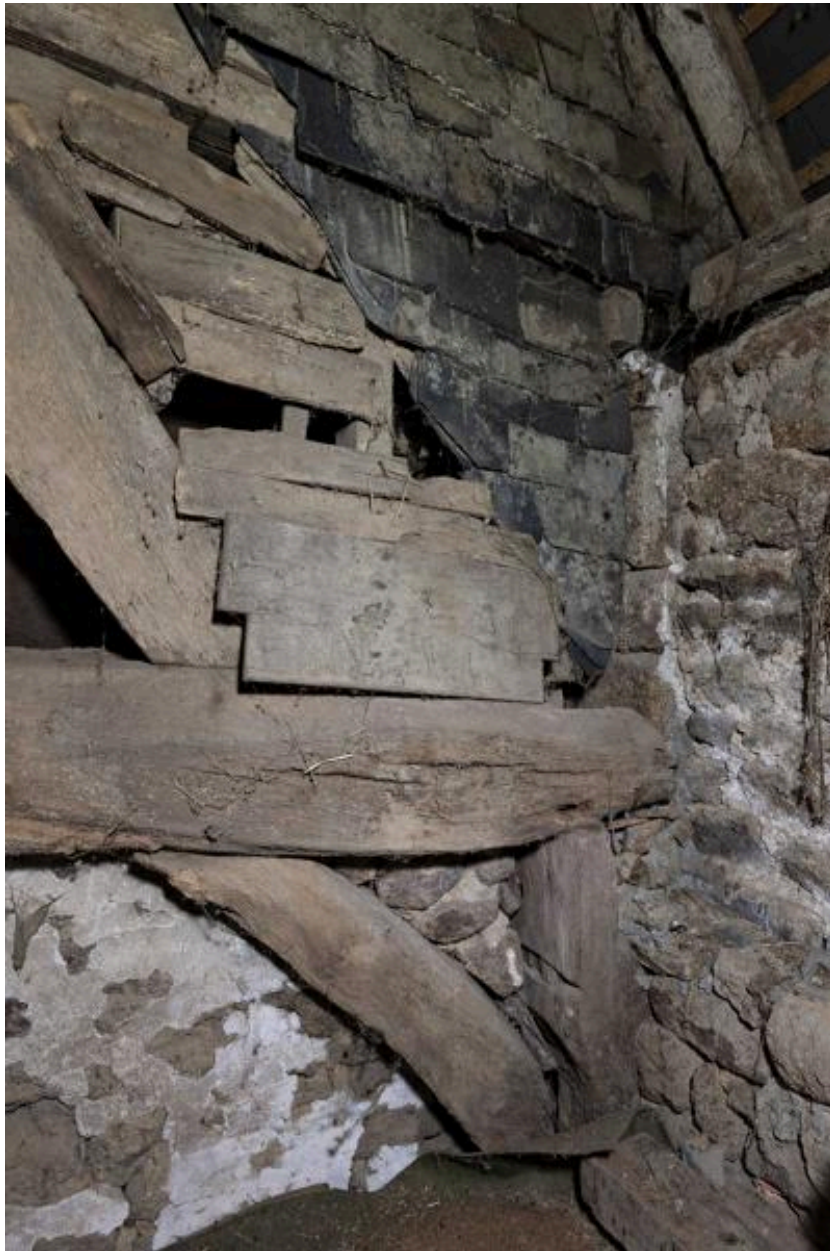
Ferme de charpente entre le comble de la maison et celui du cellier, détail de l'assemblage poteau sud, entrain, lien, arbalétrier.
