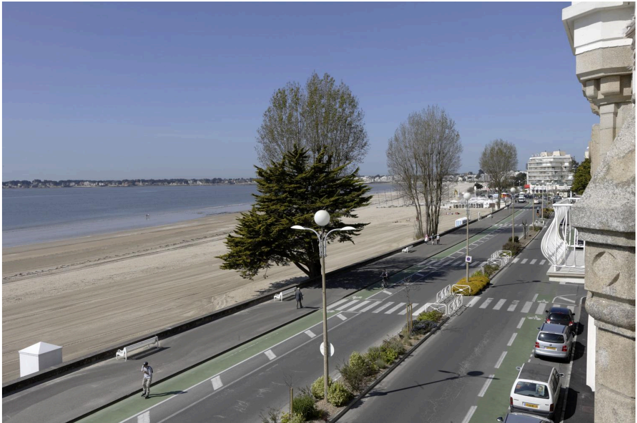
Vue du remblai de La Baule vers Le Pouliguen.
