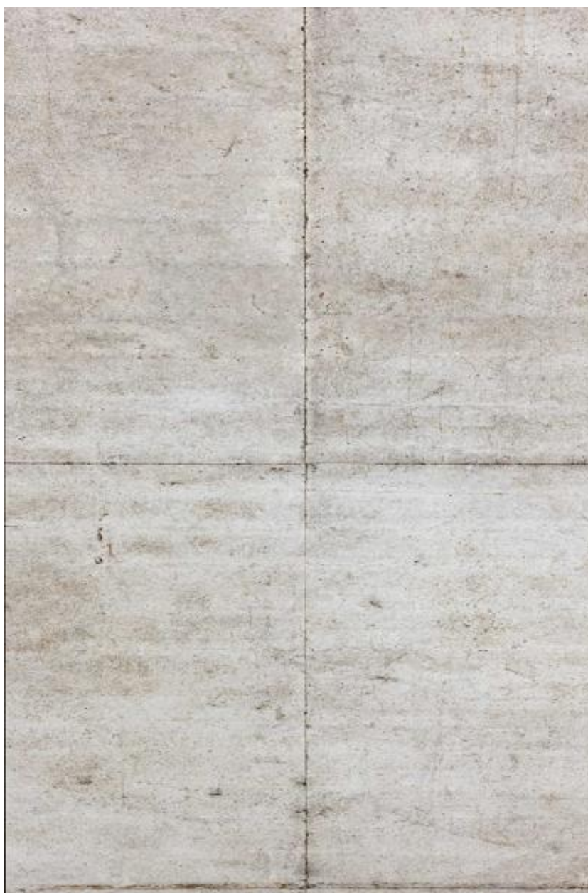
Vue des marques du coffrage béton sur le plafond du porche.
