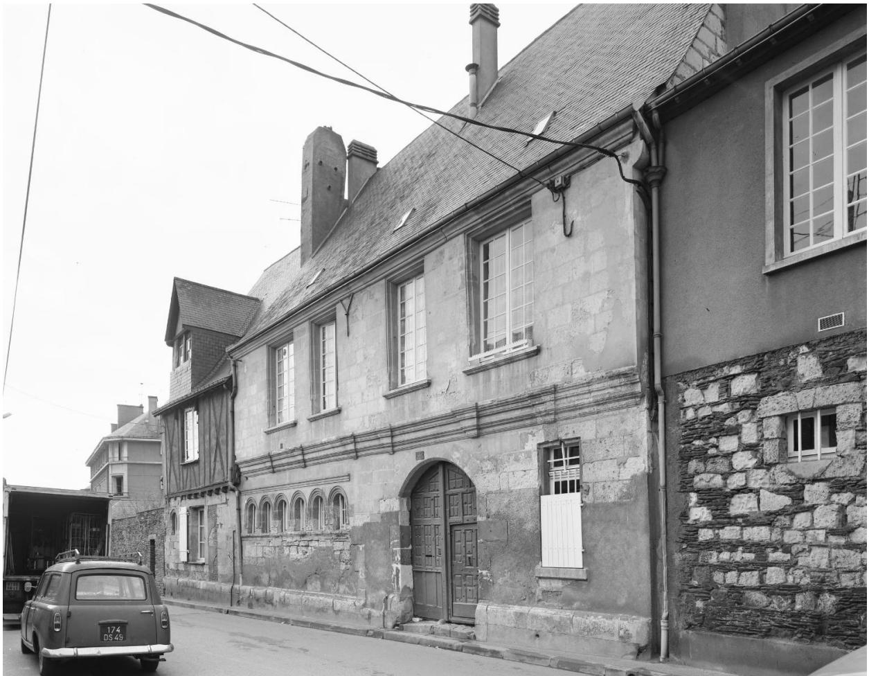
Logis de Puygaillard formant l'entrée du couvent, au n° 39 : façade sur rue, trois-quarts droit.
