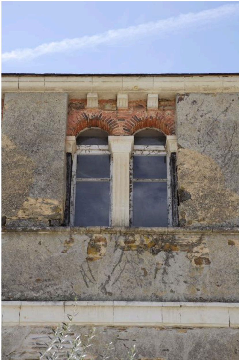
Bâtiment ouest, façade est, détail des ouvertures à l'étage.
