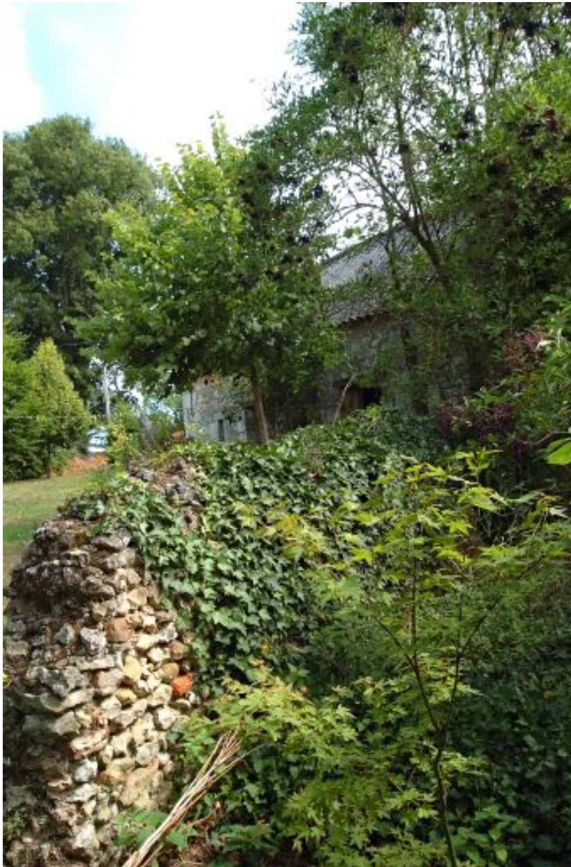
Vestiges de mur de clôture.
