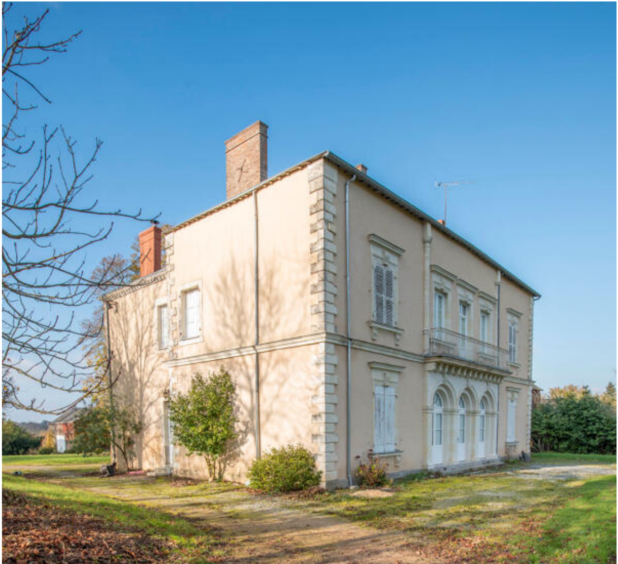
L'élévation latérale sud de la demeure.
