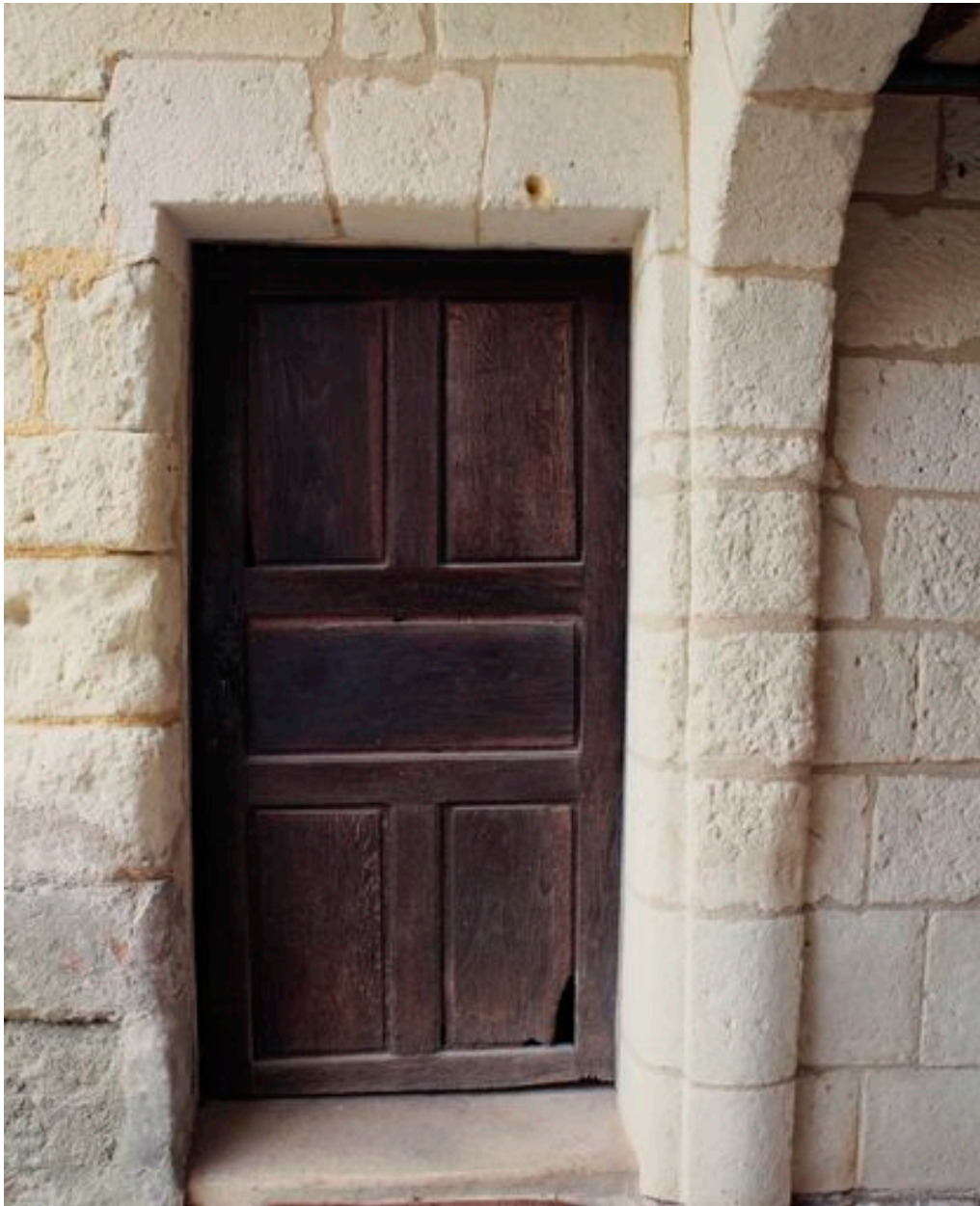
Huisseries (fin XVIIe ou XVIIIe siècle ?). Rez-de-chaussée, porte de la tourelle d'escalier.
