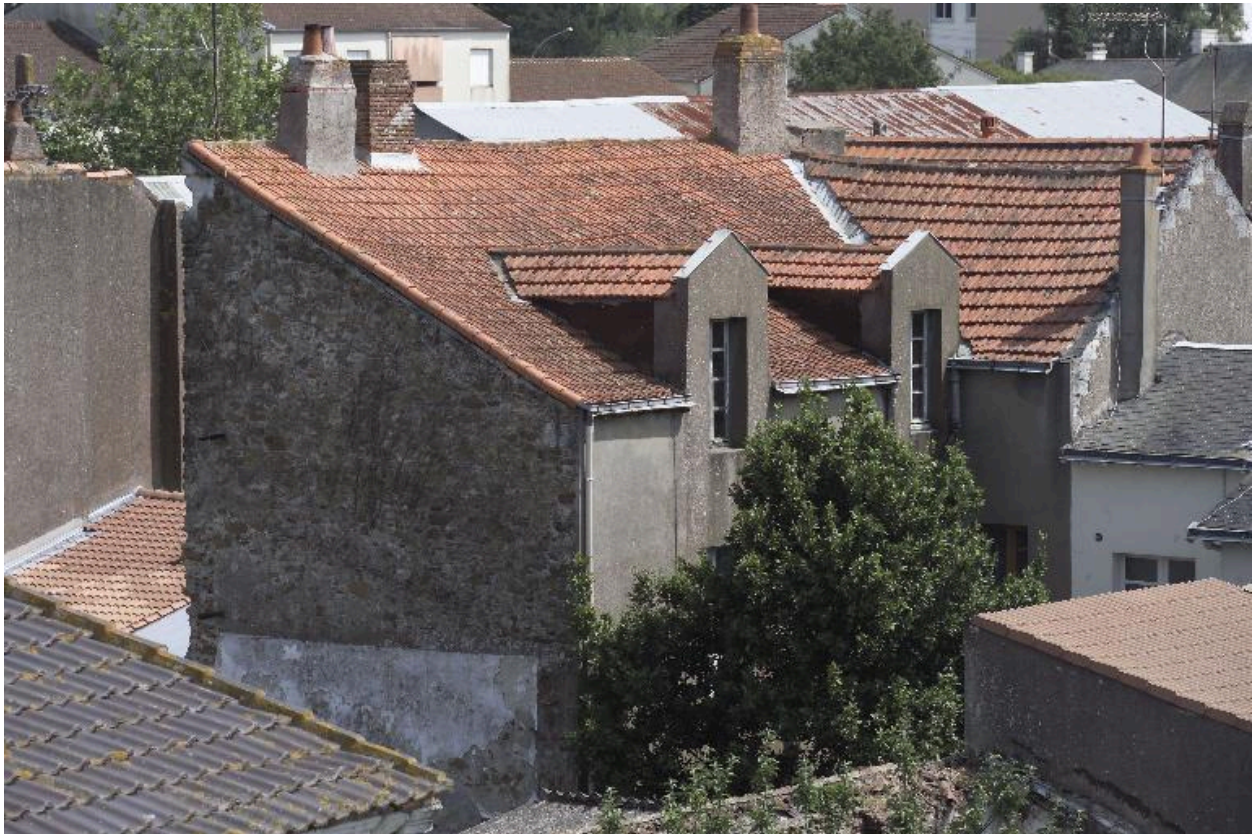
Les façades postérieures, vue prise du terrain situé à l'est.
