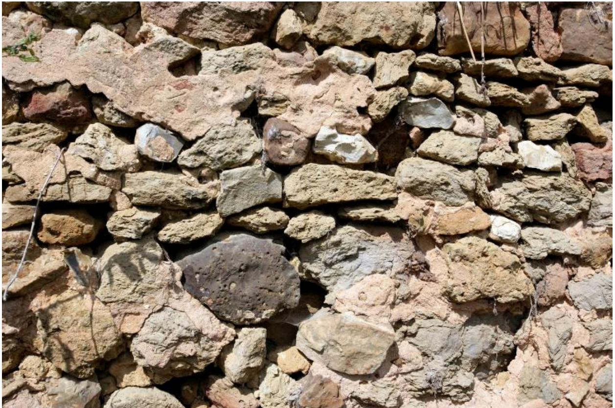
Porcheries, élévation postérieure : détail de la maçonnerie.
