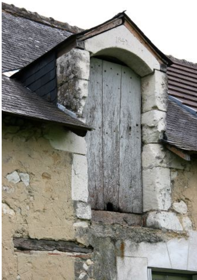
Façade postérieure : lucarne.
