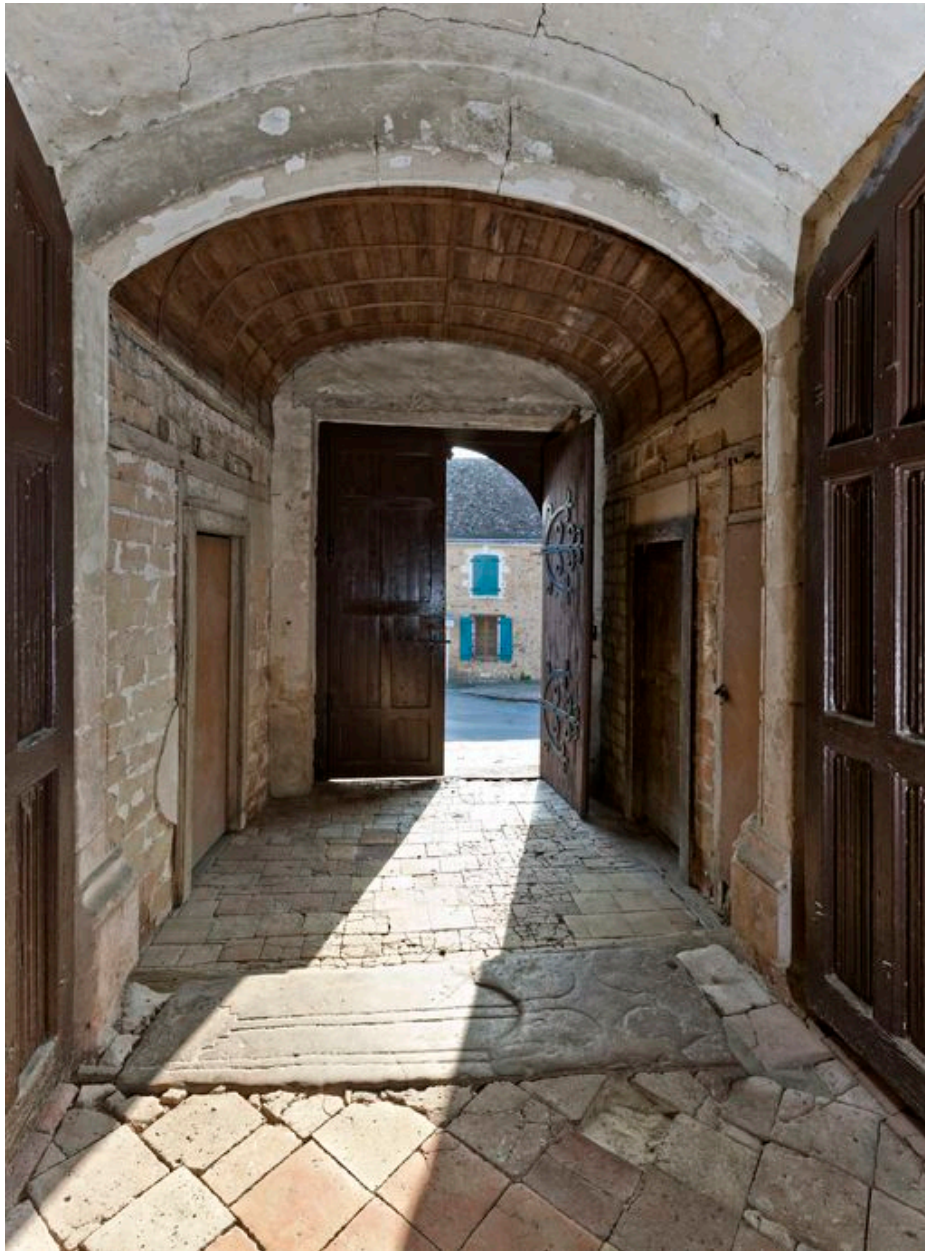
Le couloir de l'avant-corps vu depuis la nef.
