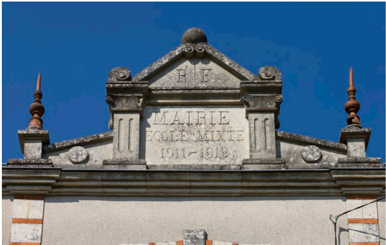
Détail du fronton de l'élévation antérieure.
