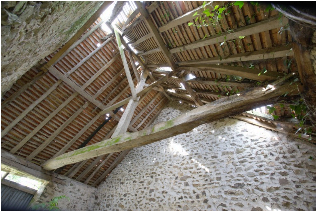
Le logis-étale ouest, partie étable : la charpente.
