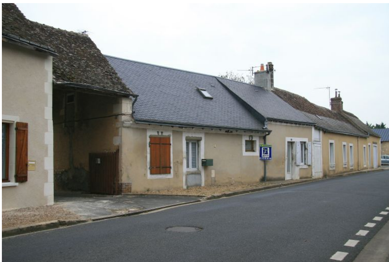
18, rue Principale : maison avec passage couvert.
