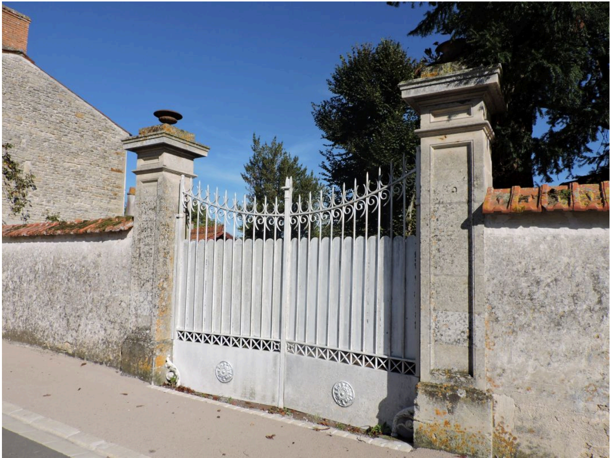
Le portail à piliers maçonnés.
