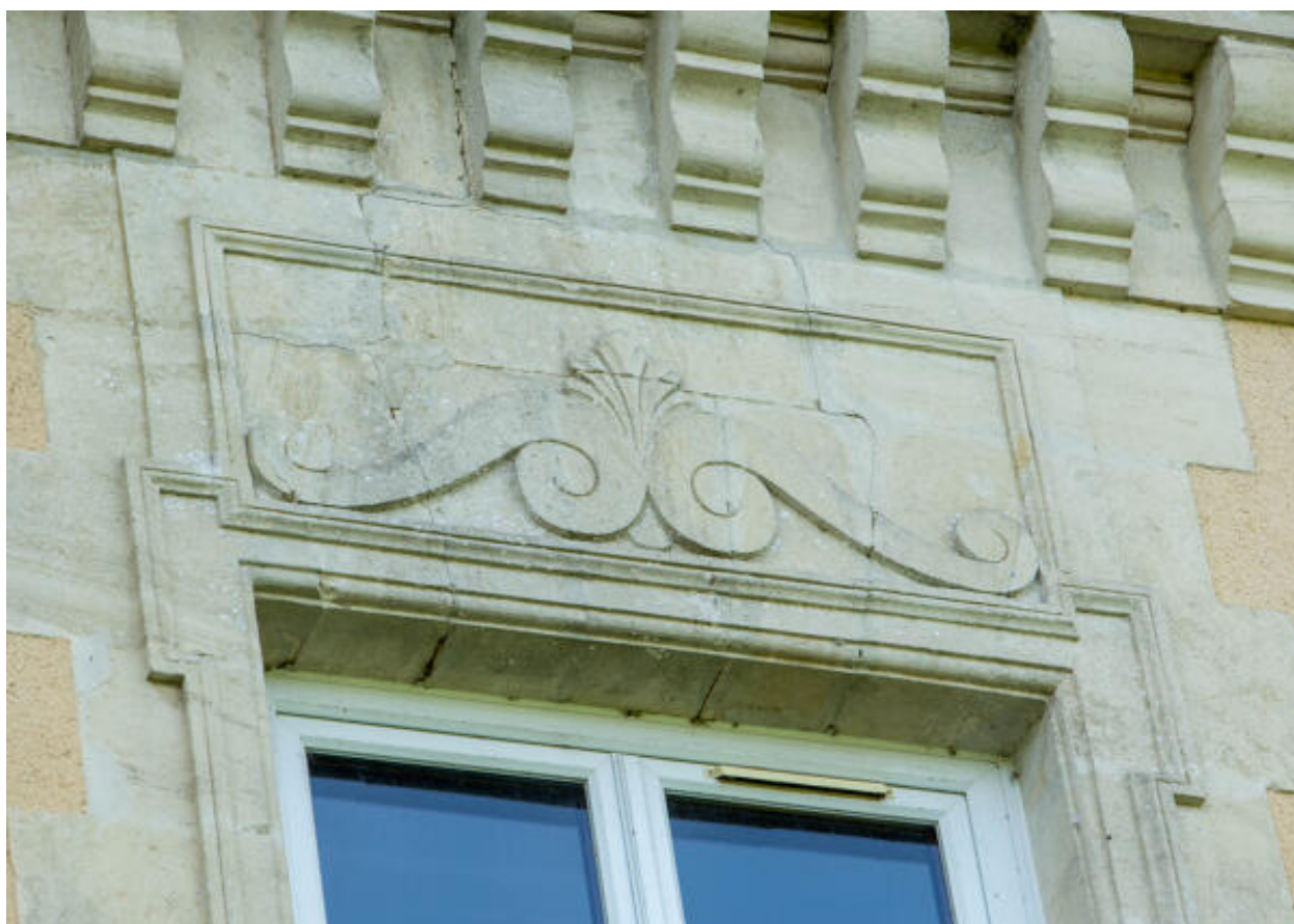
L'élévation postérieure, détail du linteau d'une fenêtre.
