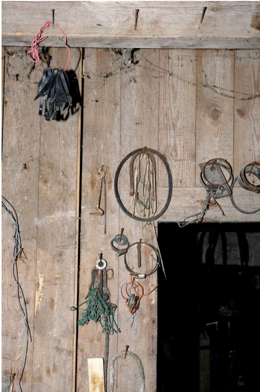
Détail du cloisonnement intérieur en planche.
