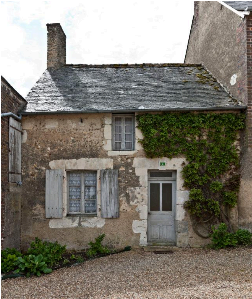
Façade antérieure sur cour.
