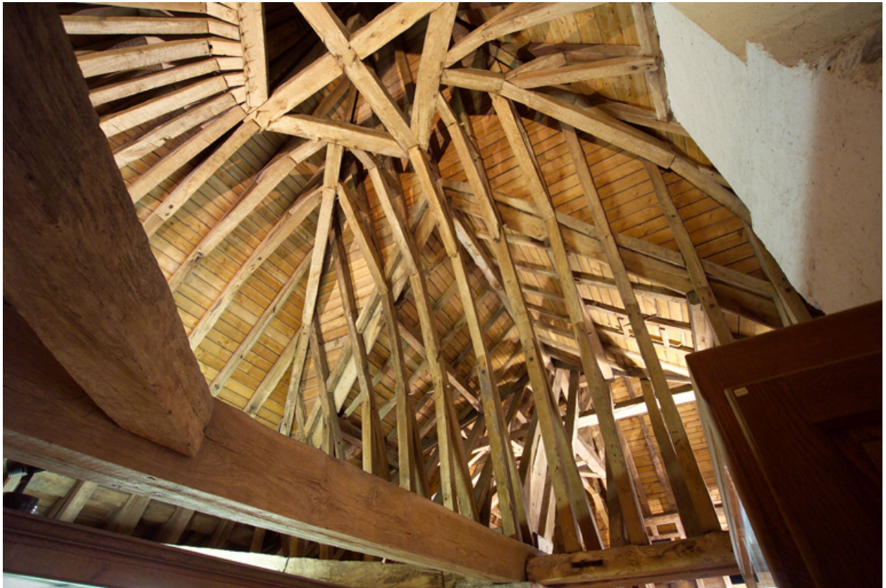
Vue de la charpente, couverture de tour.
