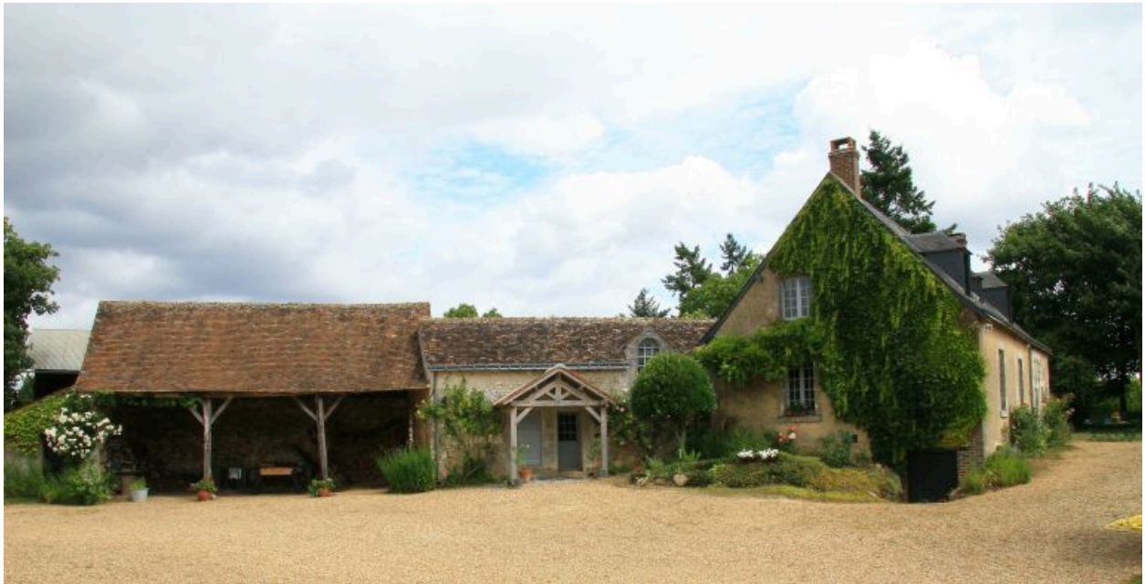
Vue d'ensemble prise de la cour : pignon moderne de la maison, toits à porcs et hangar.
