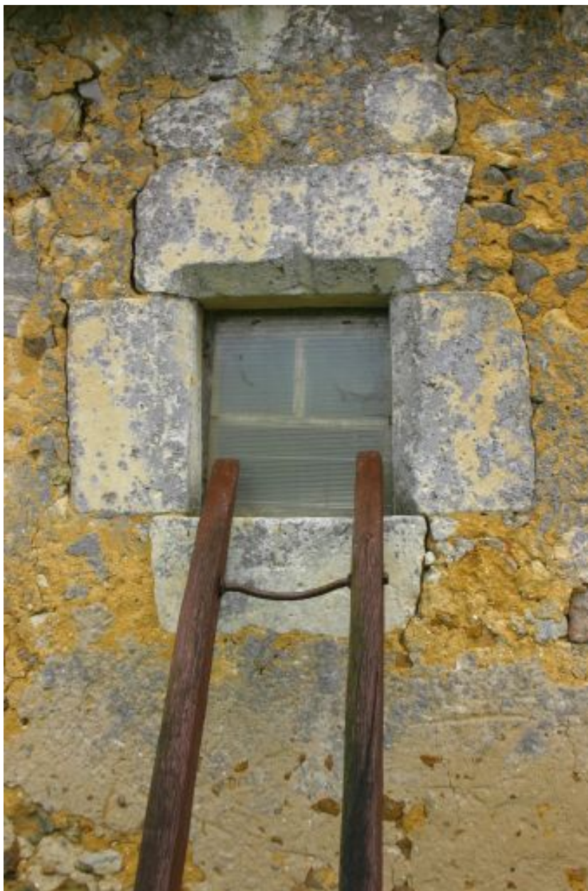
Façade postérieure : baie chanfreinée couronnée d'un gâble.
