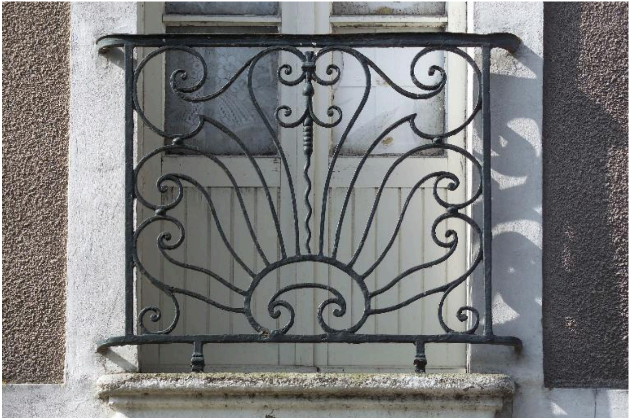
La façade antérieure, détail d'un balcon du premier étage.
