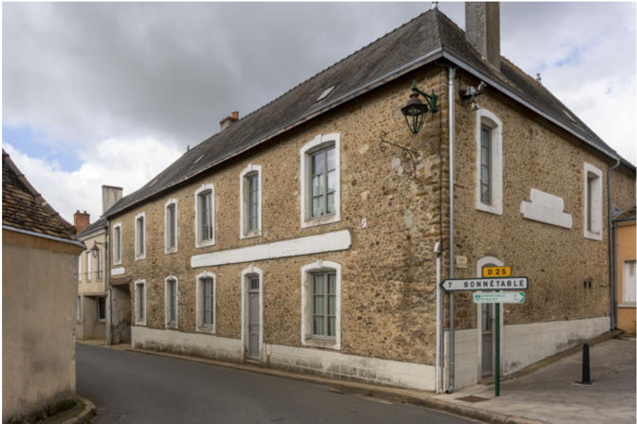
Vue de la façade principale et de la façade est de l'auberge.
