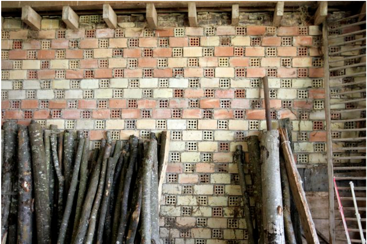
Étables, appareil de briques creuses du pignon est.
