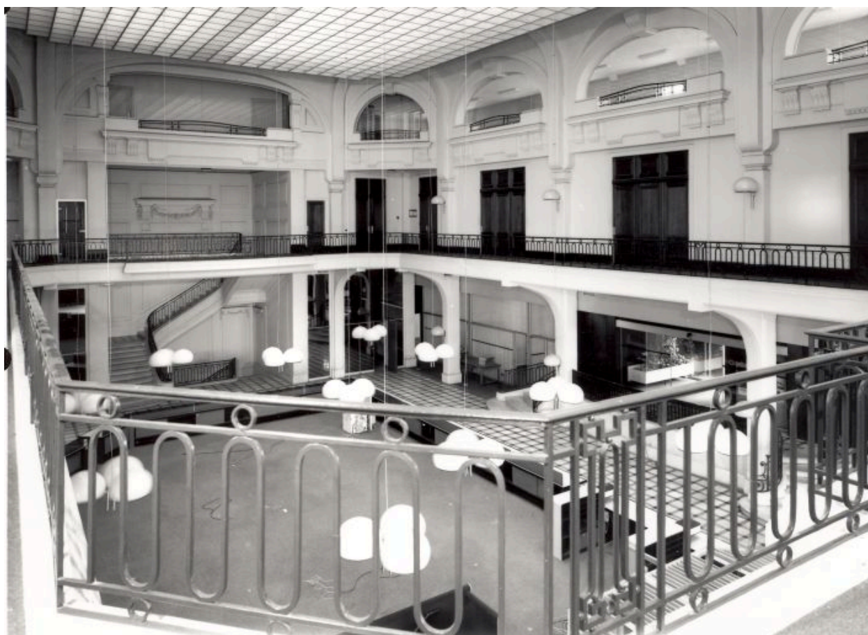
Le hall : élévations latérale droite et antérieure.
