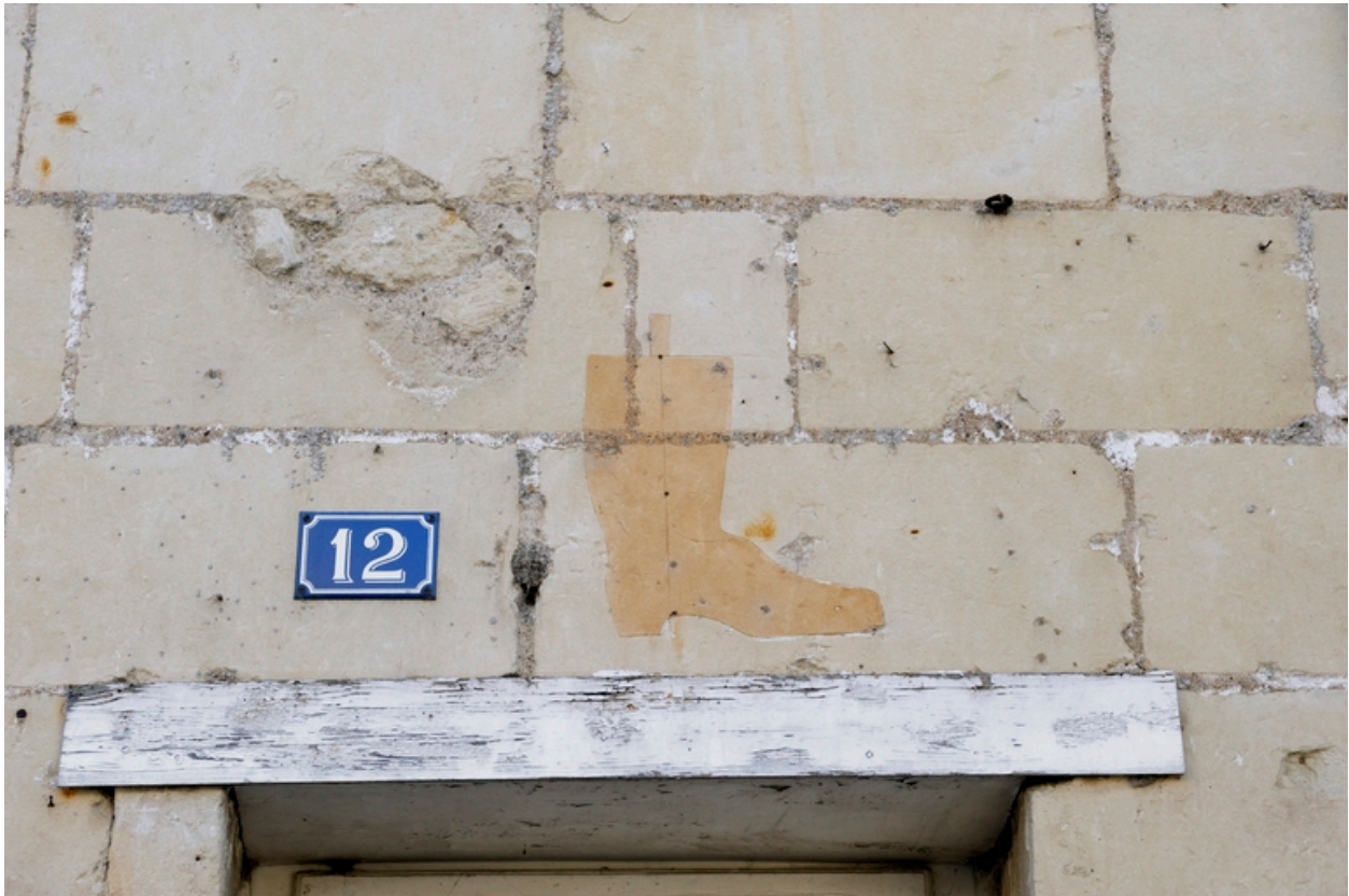
Façade, rez-de-chaussée, travée ouest : enseigne d'un bottier (XXe siècle), figurée au-dessus de l'entrée.
