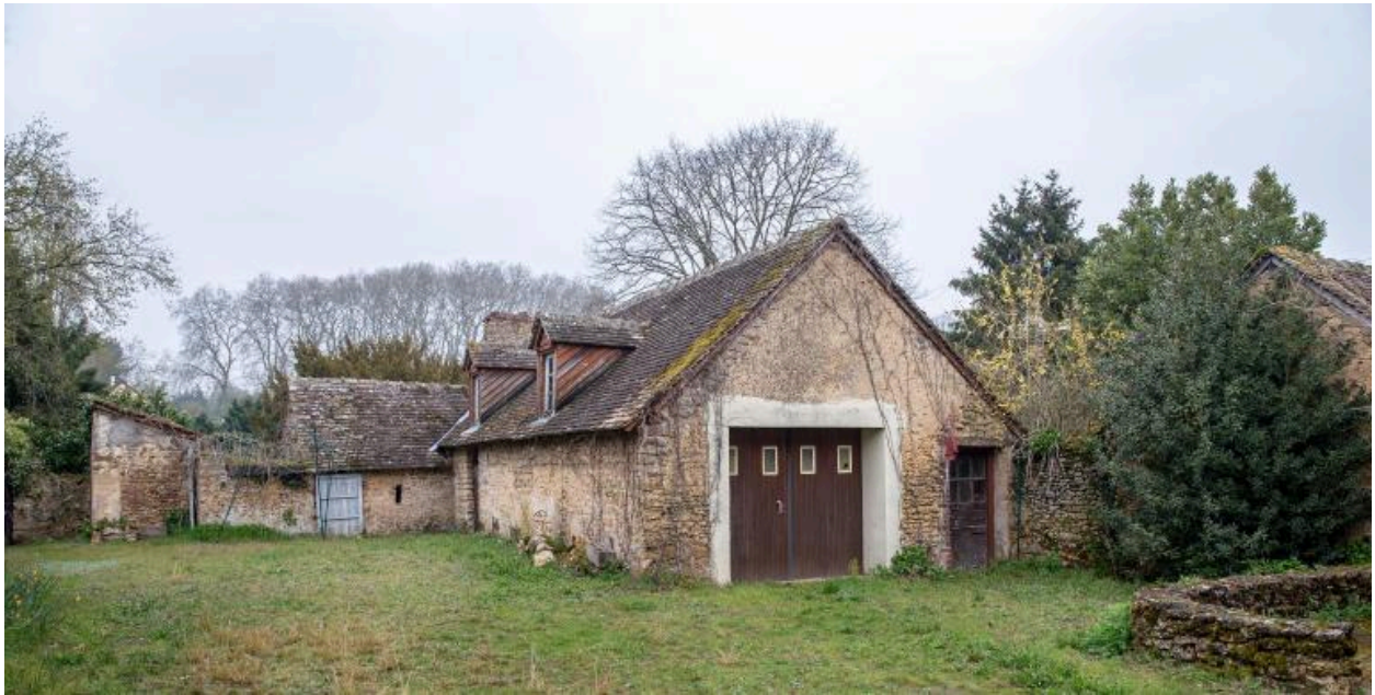
Le bâtiment abritant le four.
