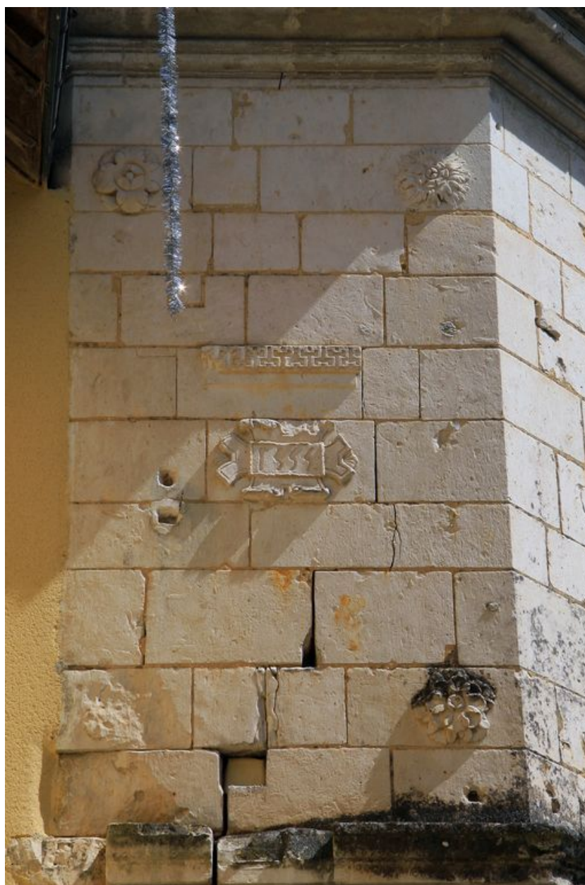
Tourelle d'escalier : cartouche.
