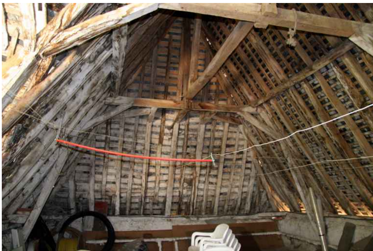
Charpente de la maison très remaniée : vestiges des anciennes fermes.
