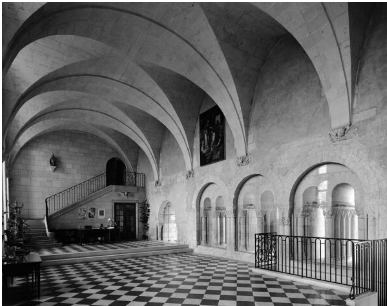
Aile orientale de l'abbaye, salle du chapitre : vue d'ensemble en axe nord-sud, avec l'élévation intérieure ouest, sur le cloître.
