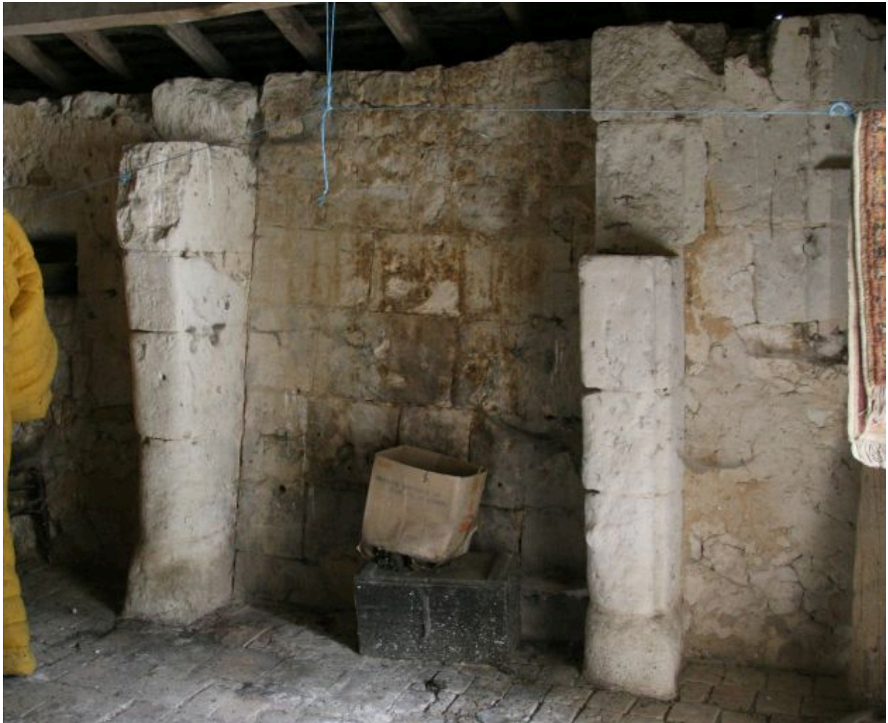
Tourelle, 1er étage : cheminée.
