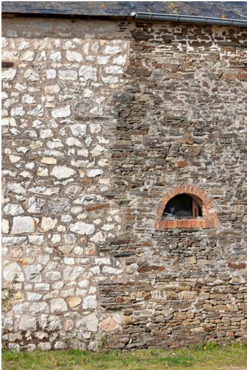
Corps de bâtiment nord-ouest, mur sud, jonction entre la maçonnerie en moellon de grès blanc et en moellon de grès.
