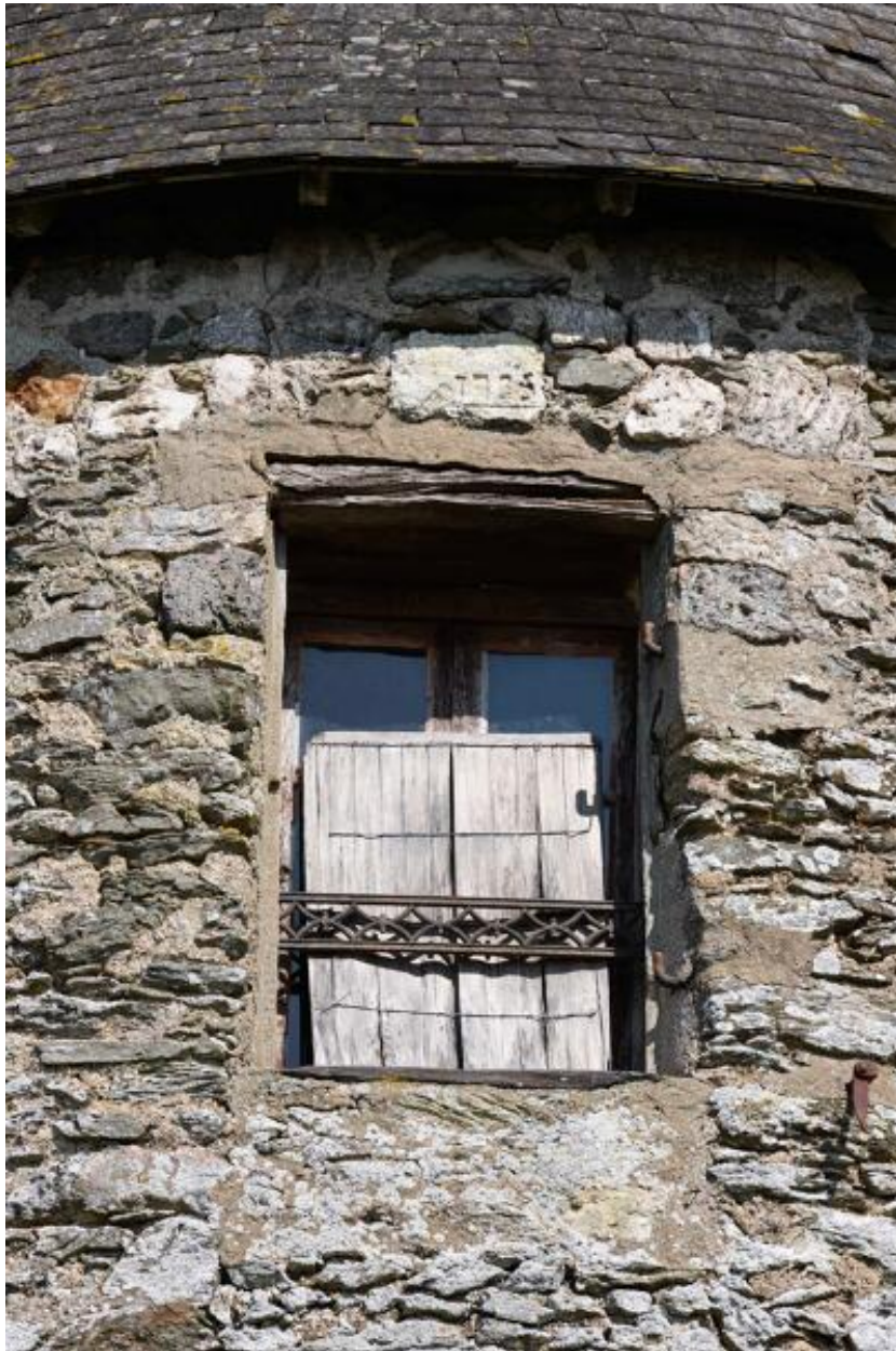
Moulin à farine dit moulin des Buttes (n° 1) ou moulin de l'Ouche-Neuve. Détail de la fenêtre ouest et de la date portée 1735.
