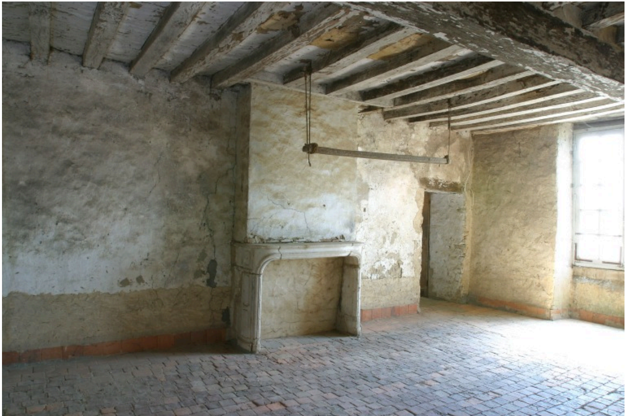
Rez-de-chaussée surélevé. La pièce 2B, vue de l'angle sud-ouest.
