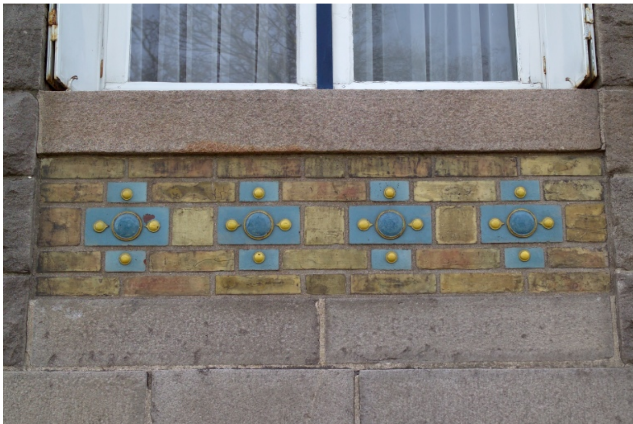
Briques vernissées dans l'allège d'une fenêtre de rez-de-chaussée.
