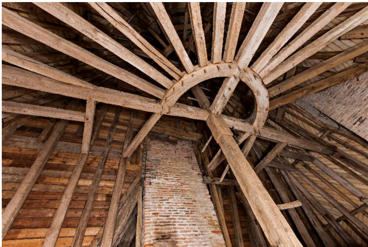
Vue partielle de la charpente de la tour nord depuis le deuxième niveau de charpente : le poinçon et l'enrayure centrale.
