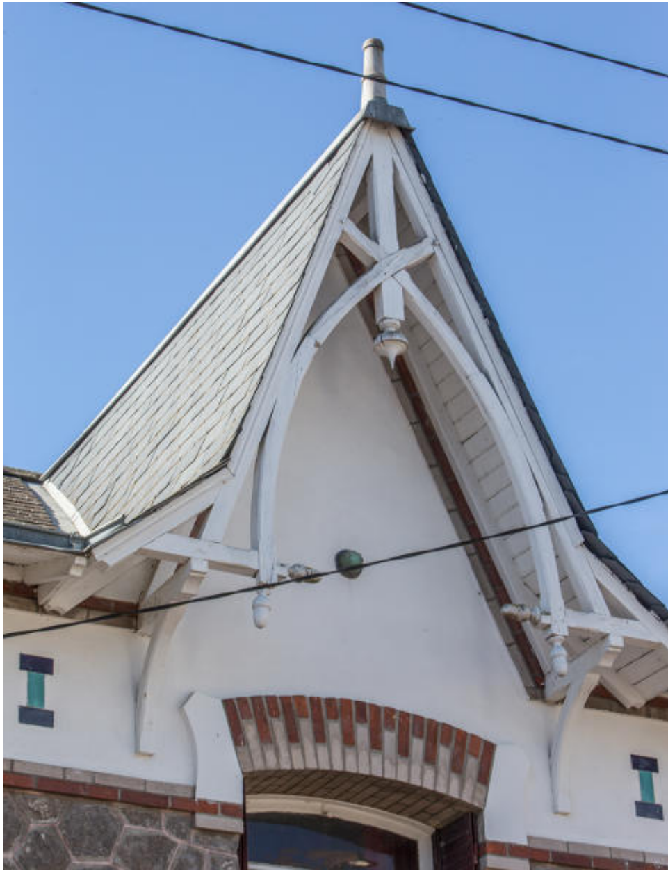
Maison, 83 rue Joseph-Tahet. Détail de la ferme débordante en toiture.
